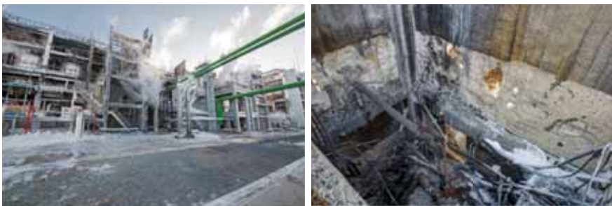
Рис. 3. Авария на наружной установке получения масла KA-Oil в производстве циклогексанона
