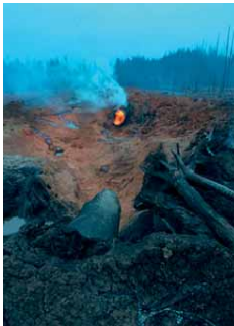
Рис. 27. Авария на магистральном газопроводе «Игрим-Серов-Нижний Тагил»
