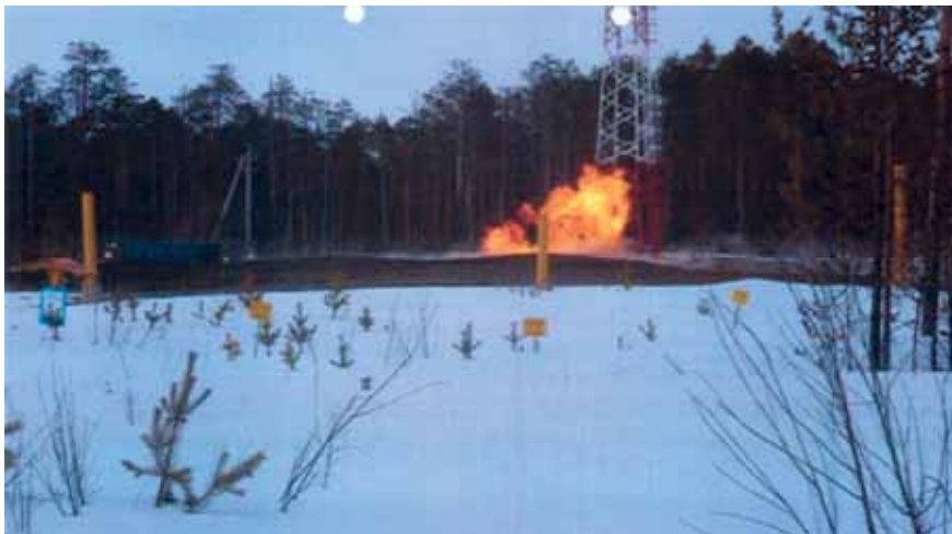
Рис. 24. Авария на трубопроводе импульсного газа узла подключения компрессорного цеха № 5 Вуктыльского ЛПУМГ
