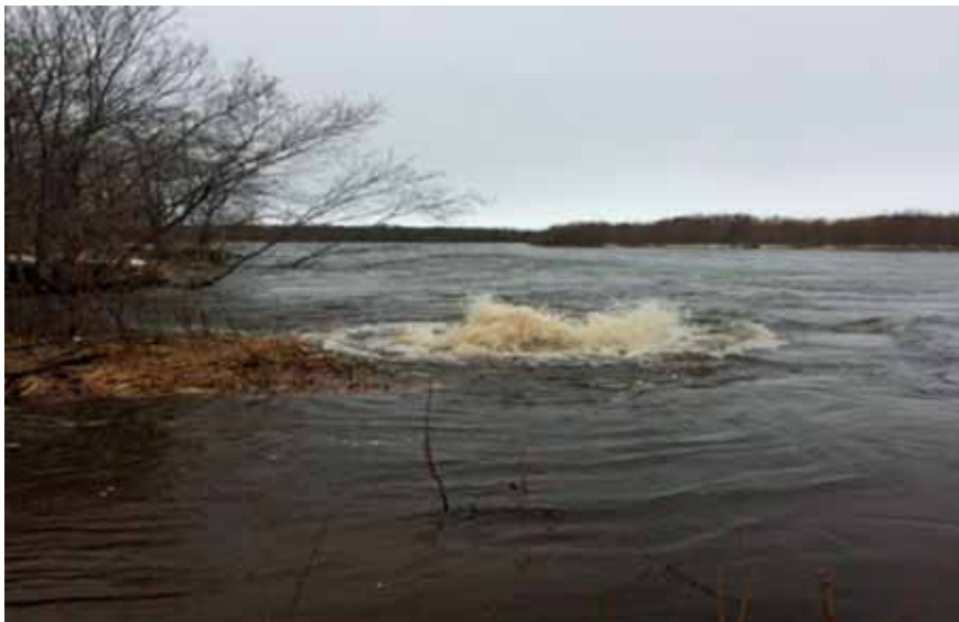
Рис. 25. Авария на магистральном газопровode «УКПГ – ГРС с. Соболево»
