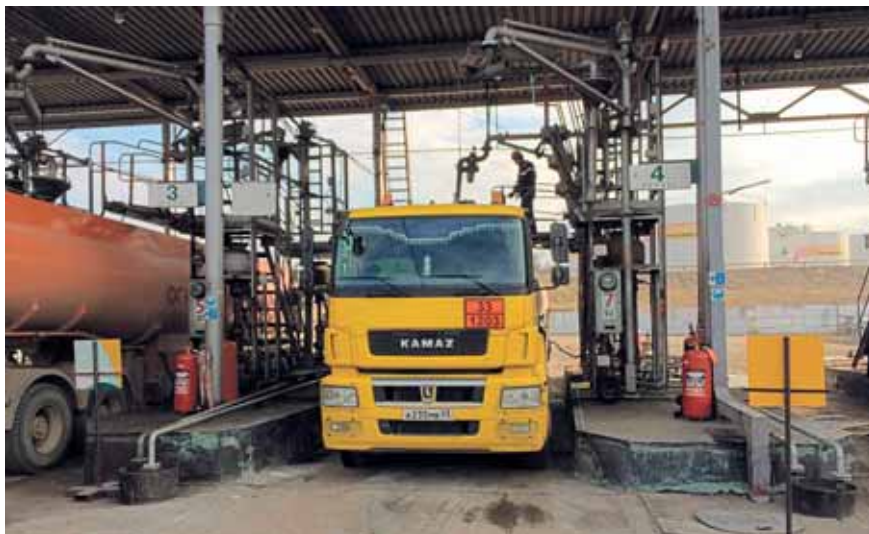
Рис. 17. Общий вид площадки автоэстакады налива нефтепродуктов
