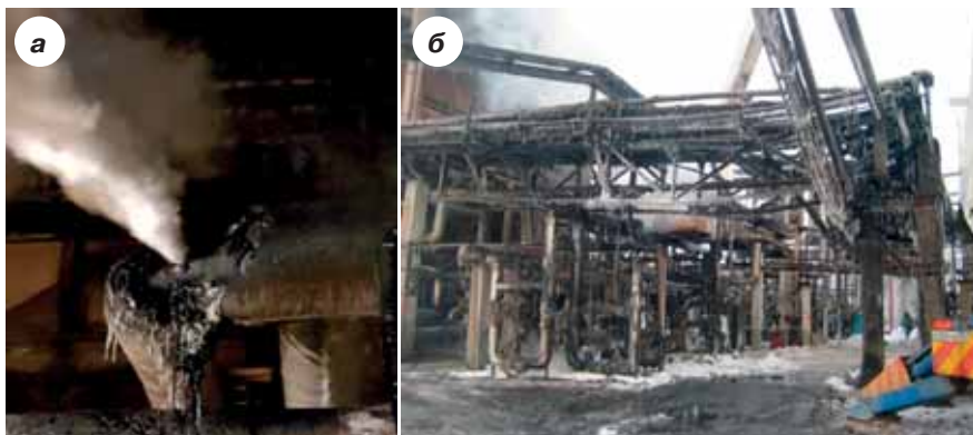
Рис. 16. Место аварии: а — разрушенный отвод трубопровода; б — общий вид на ружной установки после аварии
