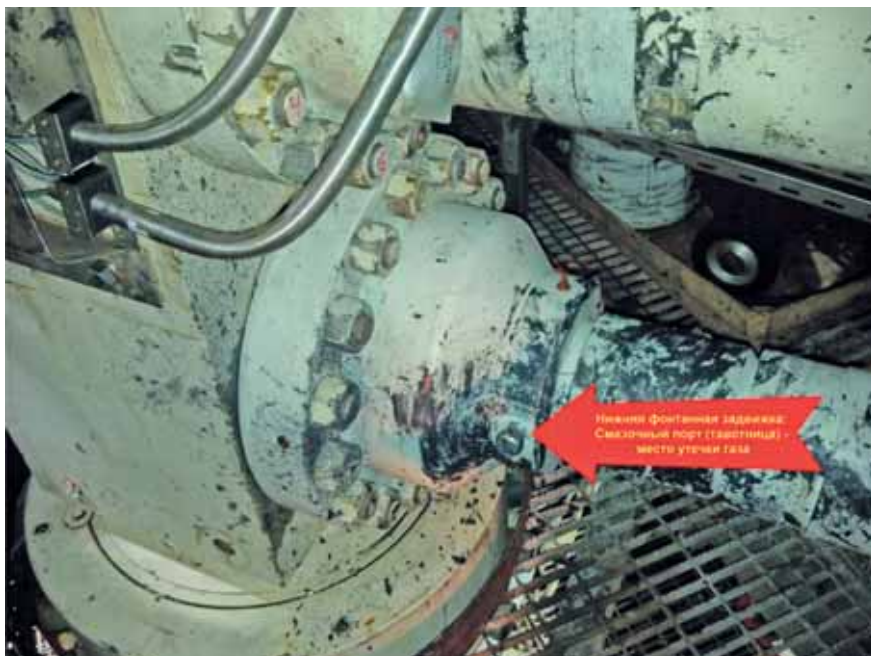
Рис. 6. Место утечки газа на морской платформе ЛУН-А
