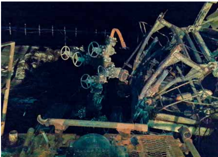
Рис. 7. Место аварии в ЗАО «КапРемСервис»
