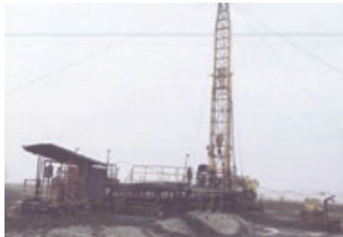
Рис. 10. Место аварии — скважина № 1551 Троицкой площади Анастасиевско-Троицкого месторождения
