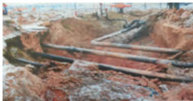
Рис. 1. Авария на узле подключения КС-06 «Ольховская» магистрального газопровода «Починки — Изобильное — Северо-Ставропольское ПХГ»
