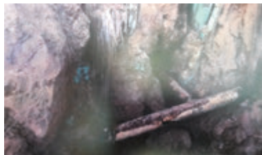
Рис. 2. Авария на конденсатопроводе «Заполярье НГКМ — г. Новый Уренгой»
