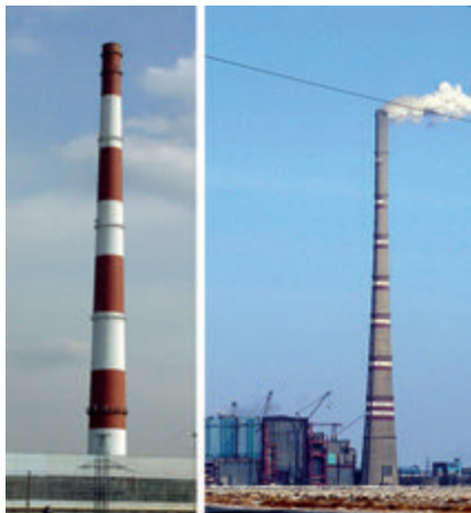
Рис. 7. Примеры железобетонных монолитных труб
