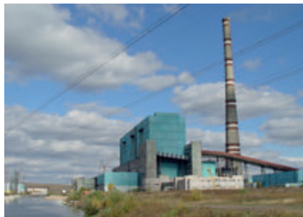
Рис. 7. Дымовая труба Березовской ГРЭС
