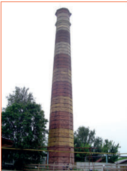
Рис. 1. Восьмигранная кирпичная дымовая труба высотой 60 м. ОАО «Меленковский льняной комбинат» г. Меленки, Владимирской обл. (1880 г.)
