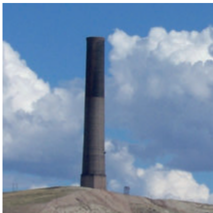
Рис. 6. Дымовая труба плавильной печи AnacondaSmelterStack
