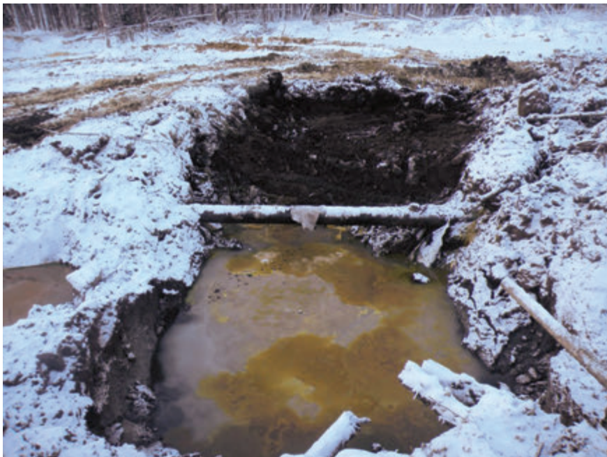
Рис. 25. Авария при проведении плановых работ по расчистке вдоль трассового проезда конденсатопровода Западный Соплеск–Вуктыл
