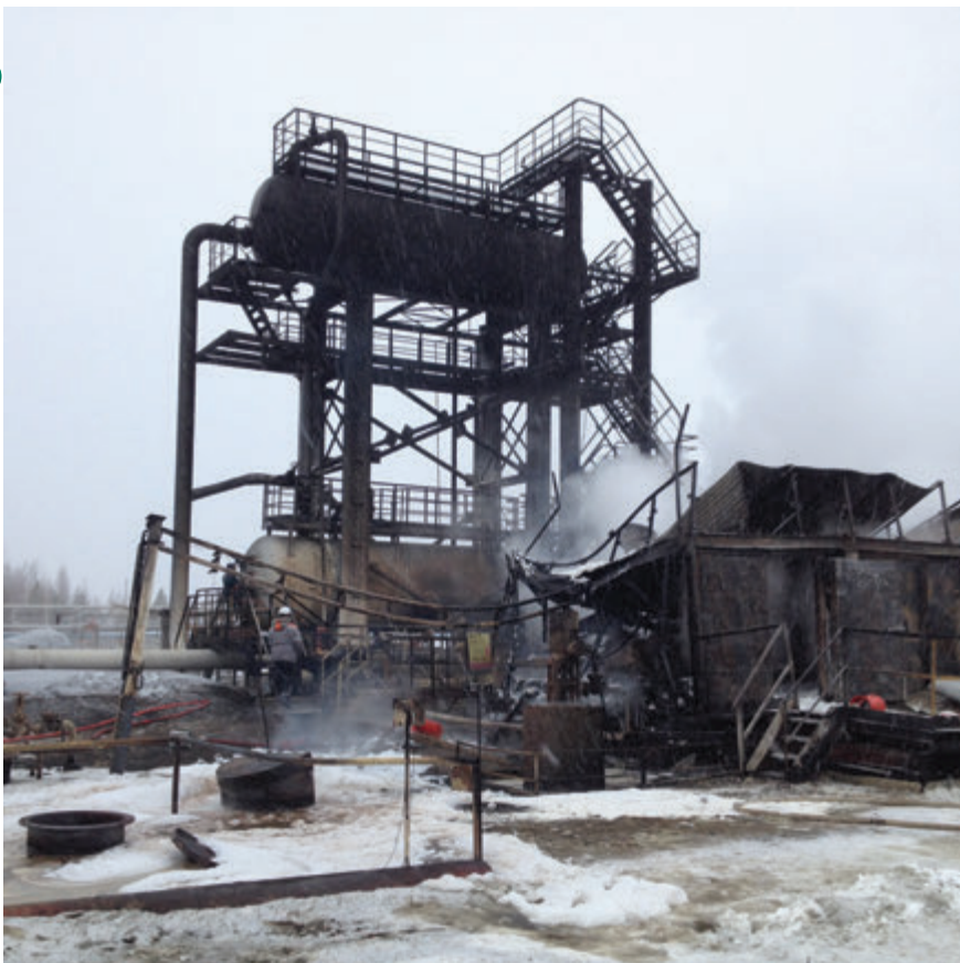
Рис. 26. Последствия аварии на ДНС-1 УНПА Север-Талинка ОАО «РН-Нягань-нефтегаз»
