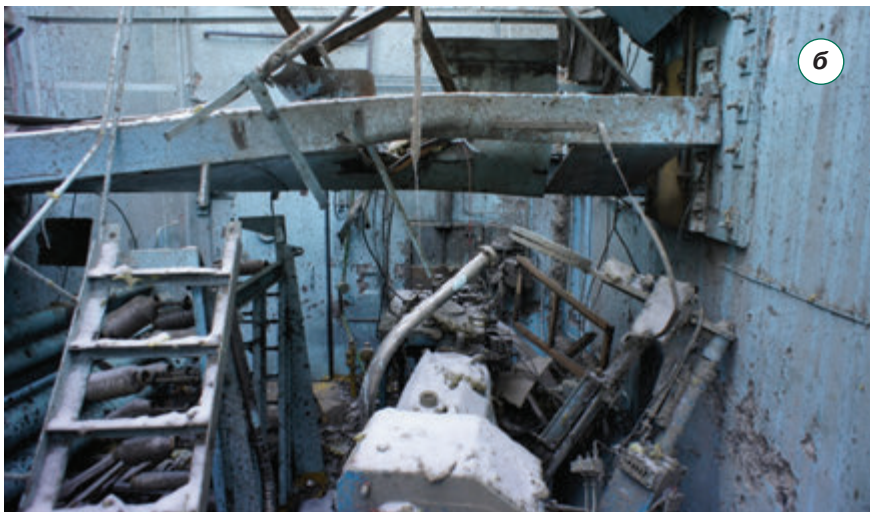
Рис. 2. Последствия аварии в ОАО «Новосибирский механический завод «Искра»
