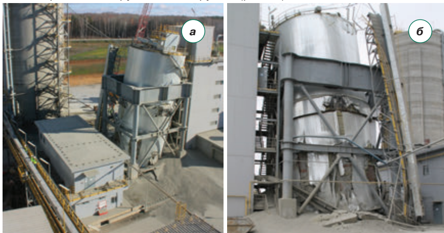
Рис. 56. Авария на Заводе по производству цемента производительностью 5000 т клинкера в сутки
