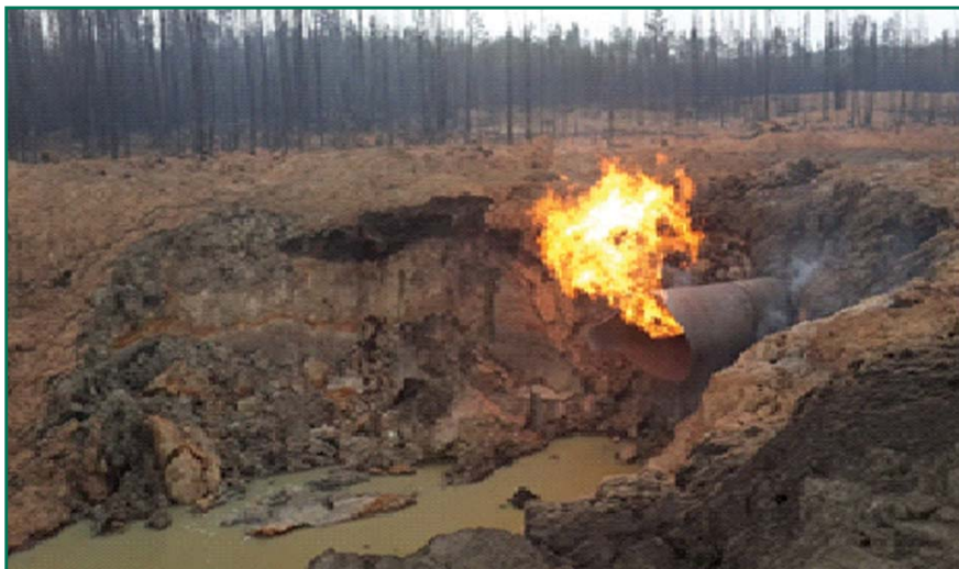
Рис. 15. Общий вид разрушения трубной секции магистрального трубопровода «Пунга–Вуктыл–Ухта 1»
