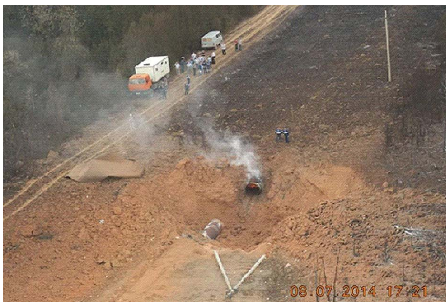
Рис. 16. Общий вид разрушения трубной секции магистрального газопровода «Торжок–Долина»
