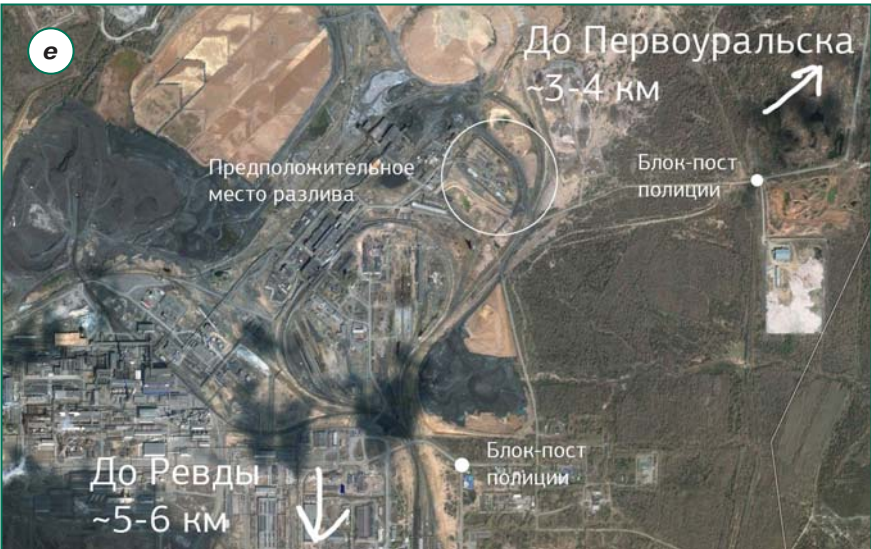
Рис. 5, а–е. Инцидент на подъездном пути ОАО «Среднеуральский металлургический завод»
