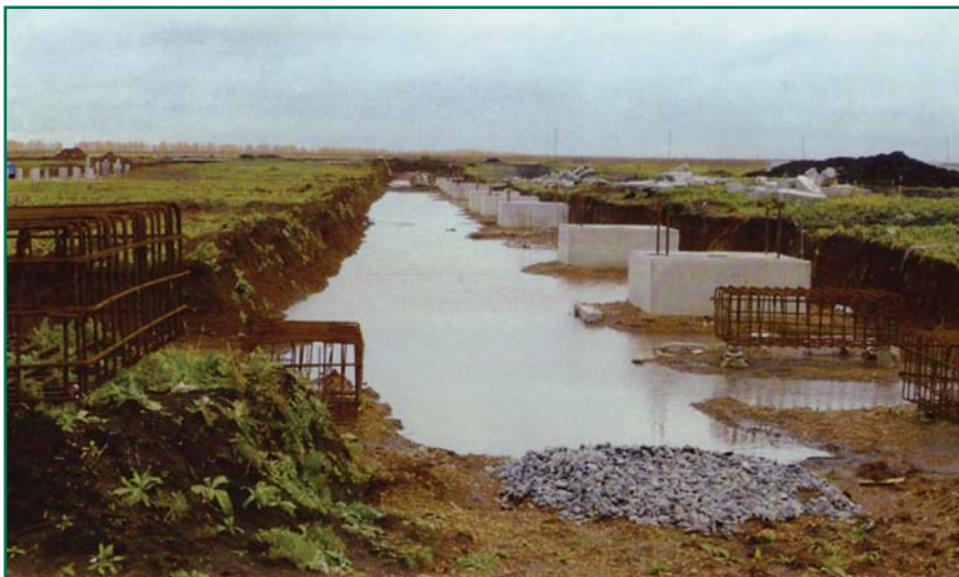
Рис. 1. Строительная площадка завода «Кроношпан» в Республике Башкортостан
