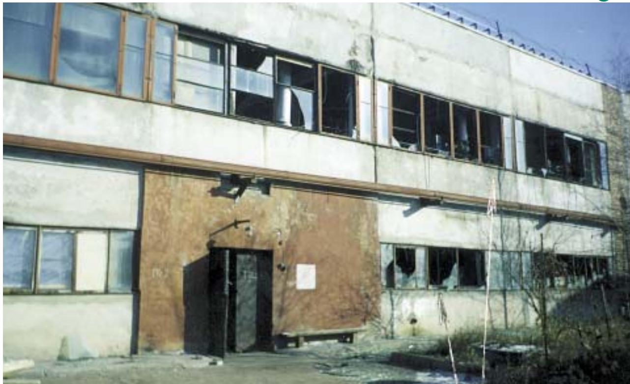
Рис. 2. Авария в котельной ООО «Братский кирпичный завод» в г. Братск 19.10.02 г. (взрыв газа в котельной), повлекшая за собой групповой несчастный случай (3 человека, из них 1 погиб)
