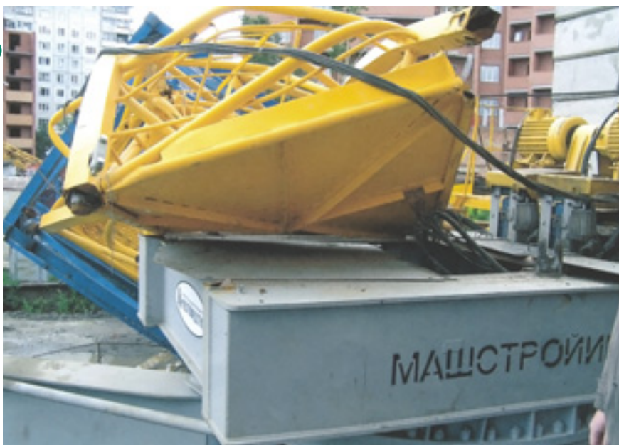
Рис. 6. Место аварии башенных кранов КБ-415-04 и КБ-403 Б в ОАО «Строй-механизация»
