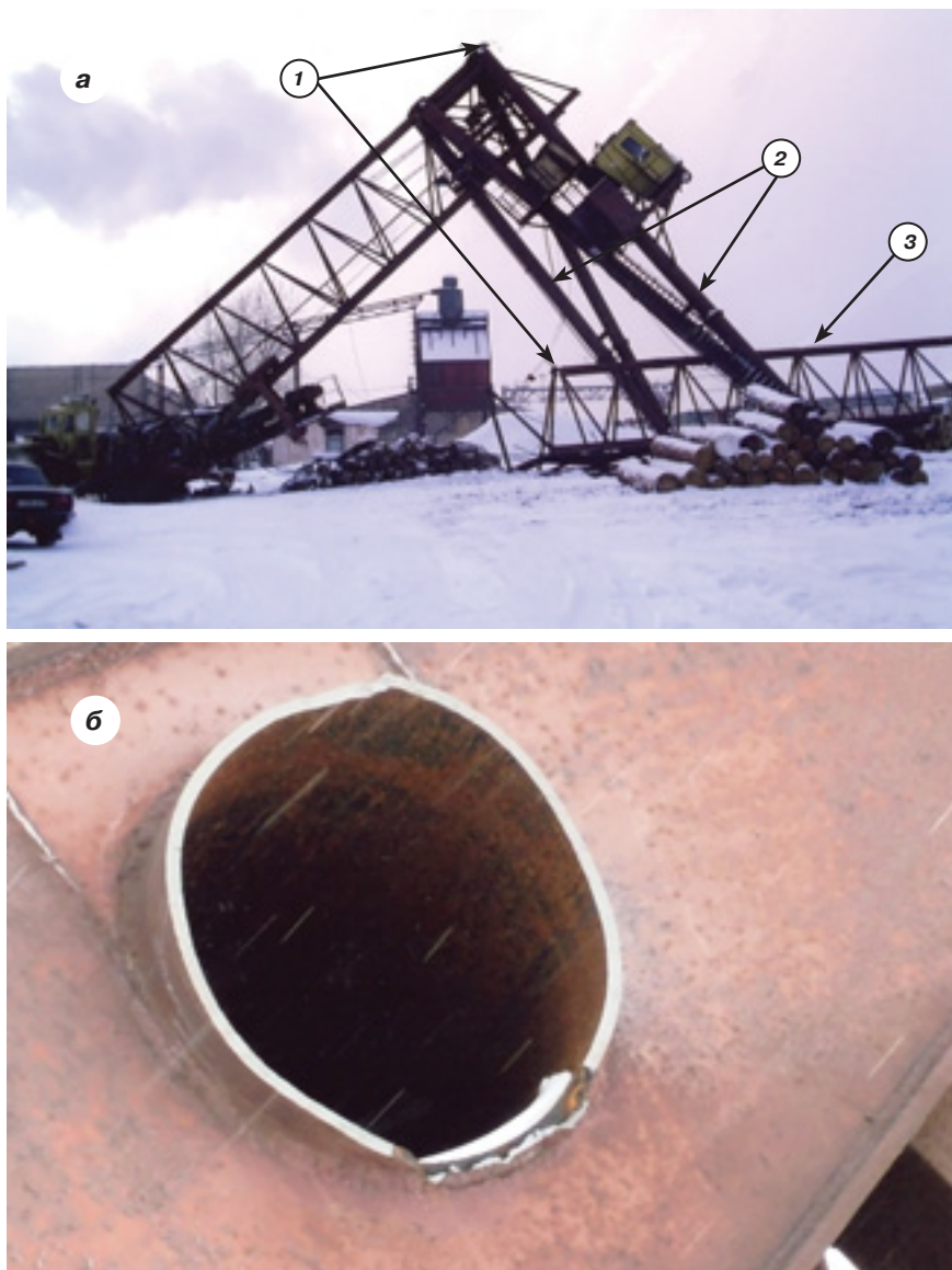
Рис. 1. Последствия аварии козлового крана МККС-32М в ООО «Айсберг-Сибирь», а: 1 – места разрушений; 2 – жёсткие опоры; 3 – труба верхнего моста крана; б – видимая часть одной из трещин в металле секции трубы моста
