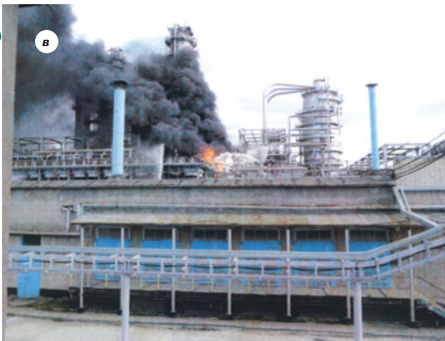
Рис. 5. Место аварии в ОАО «Саратовский НПЗ»: а – вид на установку ЭЛОУ-АВТ-6 со стороны административного здания цеха № 4; б – применение водяного орошения для охлаждения оборудования в зоне аварии; в – пенная атака на очаг горения
