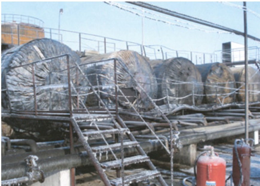
Рис. 1. Резервуарный парк нефтепродуктов после аварии
