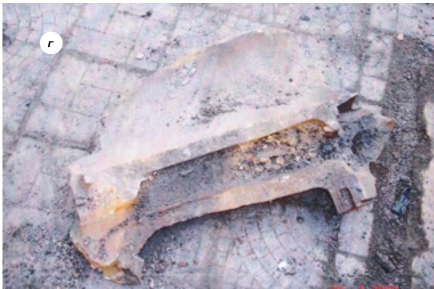
Рис 2. Последствия аварии в ОАО «Уфимский НПЗ»: а – общий вид компрессорной; б – вид здания компрессорной с восточной стороны; в – общий вид разрушенного цилиндра; г – фрагмент оторванной части корпуса цилиндра
