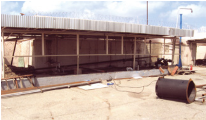
Рис. 6. Место проведения ремонтных работ на складе нефтепродуктов в ООО «Лабавтосервис»
