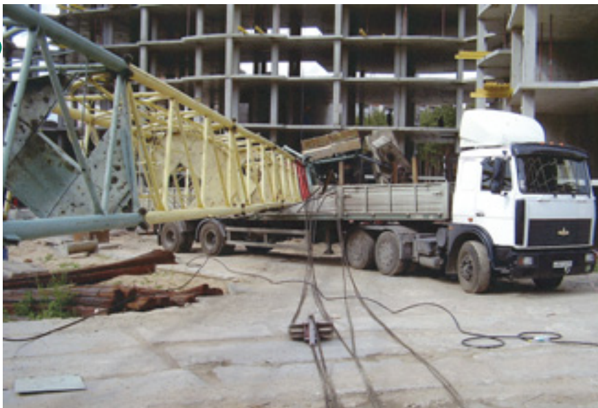
Рис. 5. Последствия аварии (падение башенного крана КБ-403А) в ООО «Выбор»
