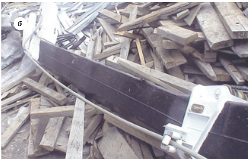
Рис. 3. Последствия аварии в ООО «Омега» (а); место падения люльки (б)
