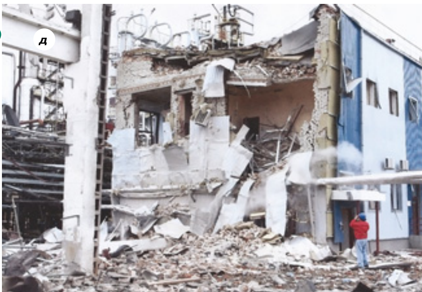
Рис. 4. Последствия аварии в ООО ПО «Киришинефтеоргсинтез»: а – разрушенное здание компрессорной; б и в – компрессорная установки ЛГ-24/7-1200; г – компрессор ПК-2; д – здание операторной установки ЛГ-24/7-1200
