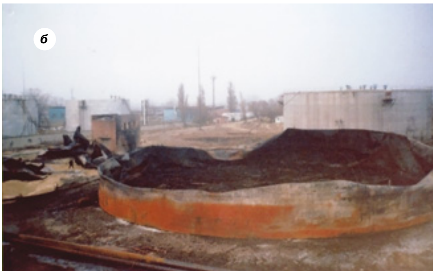
Рис. 2, а и б. Последствия аварии (деформированный резервуар) и место несчастного случая в ОАО «Дагнефтепродукт»
