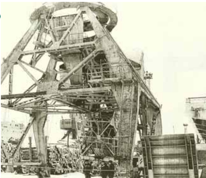
Рис. 1. Последствия аварии портального крана марки «GANZ»
