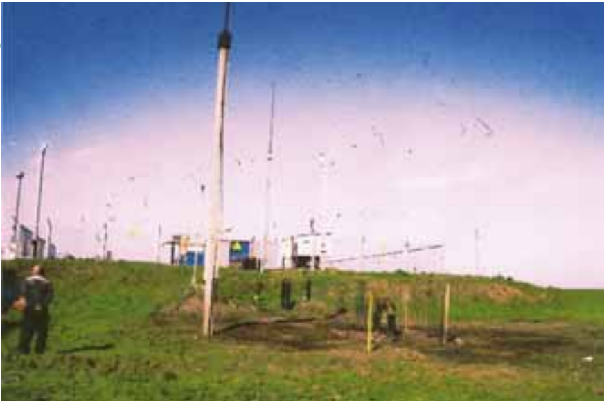
Рис. 3. Место аварии на межпоселковом трубопроводе в ОАО «Оренбург-облгаз»
