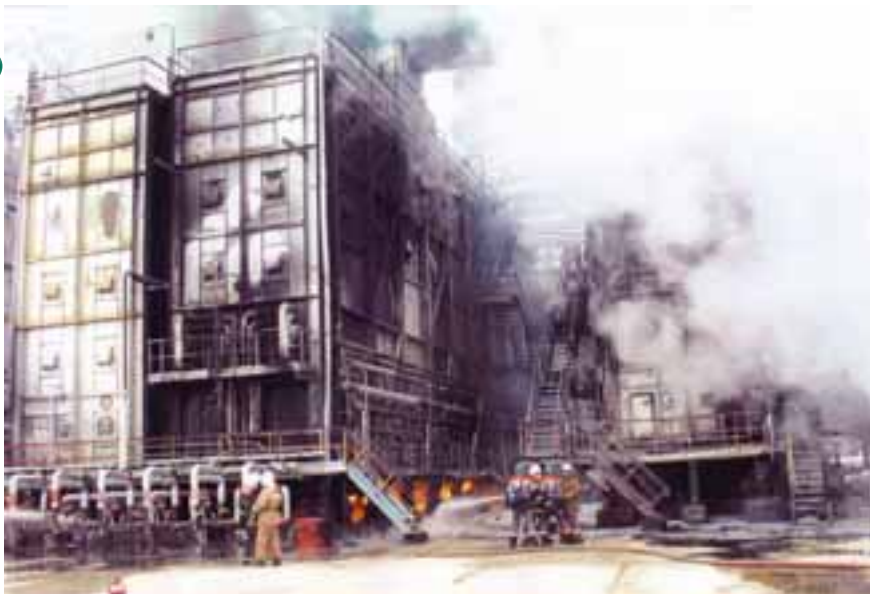
Рис. 6. Общий вид печи вакуумного блока установки ЭЛОУ-АВТ-6 в ОАО «Саратовский НПЗ» после аварии
