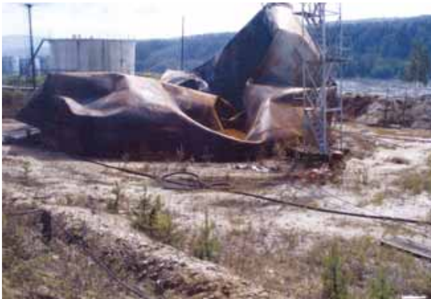
Рис. 8. Вид резервуара, на котором проводились огневые работы, после взрыва (ООО «Витимсервис»)
