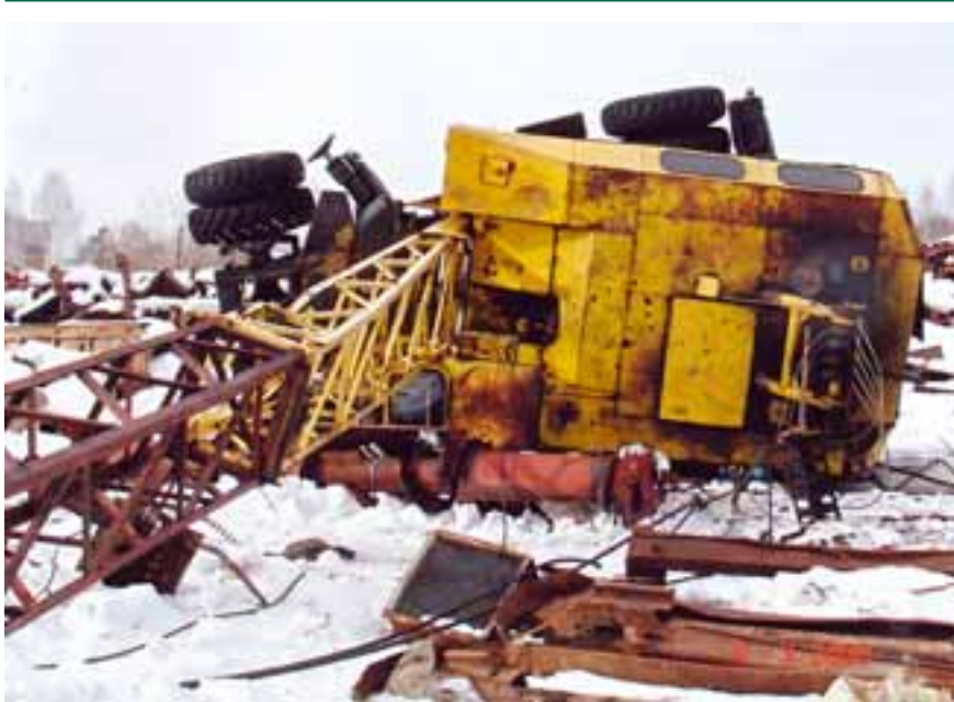
Рис. 2. Последствия аварии пневмоколесного крана KC-4361A
