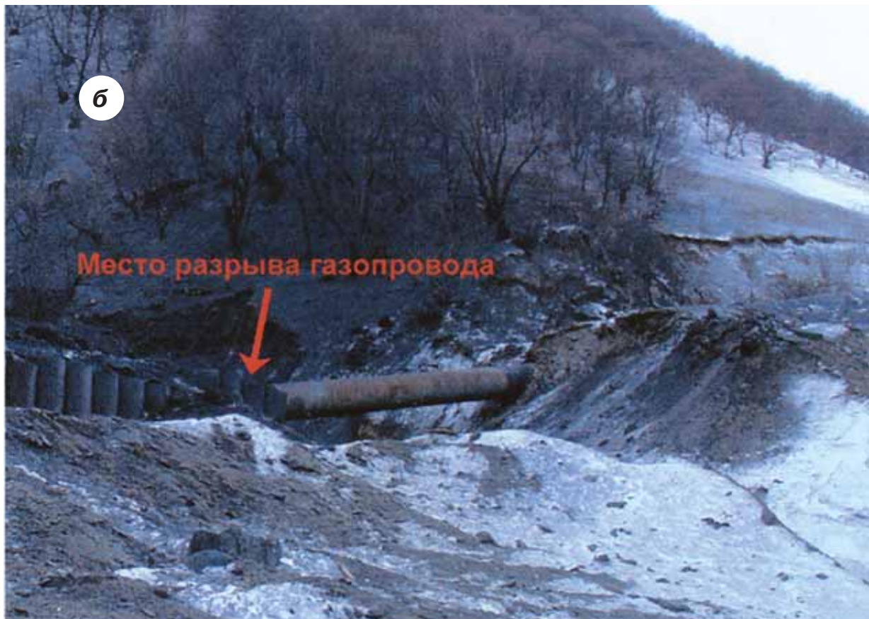
Рис. 7. Место разрыва магистрального газопровода «Северный Кавказ–Закавказье» (133-й км)
