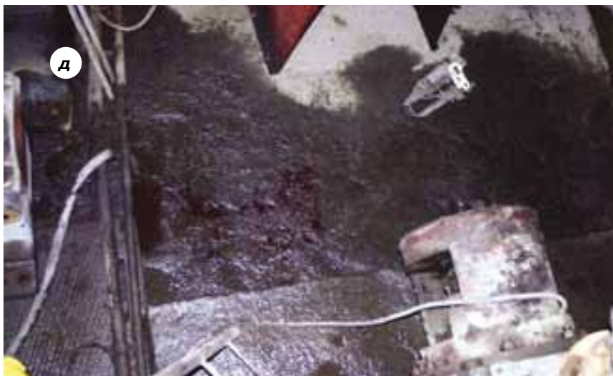
Рис. 3, а–д. Место несчастного случая в руднике «Октябрьский»: а – ограждение площадки (находящейся между задвижками на ответвлениях напорного трубопровода), имеющее проем шириной 1200 мм и высотой 850 мм; б – площадка (полок) с лежащими на ней зубилом слесарным с приваренной ручкой и открытой пачкой с электродами; виден верхний край лестницы, опирающейся одной тетивой на опорный двутавр основного става нагнетательного трубопровода, другой – на противопожарный трубопровод; в и г – переносная неинвентарная лестница длиной 3610 мм, без специальных крюков-захватов в верхней части и башмаков противоскольжения в нижней; д – северо-восточный угол фундамента насосного агрегата
