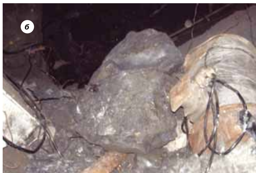
Рис. 6, а и б. Место несчастного случая в Рубцовском руднике ОАО «Сибирь-Полиметаллы»: а – внутрислоистовые трещины в месте обрушения; б – куски обрушившейся породы
