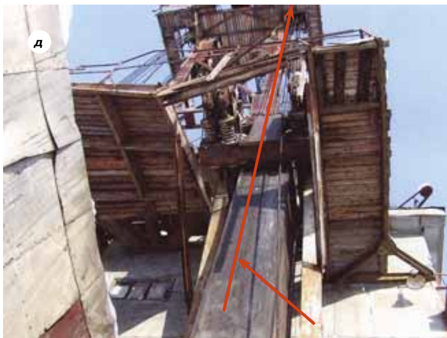
Рис. 4, а–е. Место несчастного случая в ЗАО «Светлый»: а – общий вид; б – место нахождения пострадавшего в момент, предшествовавший несчастному случаю; в – место нахождения погибшего (муляж); г – место обрыва подкоса площадки; д – путь подъема вала блока полиспаста подвеса свай; е и ж – схемы места несчастного случая
