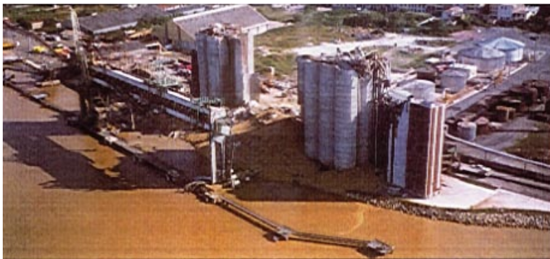
Элеватор после взрыва пыли (Франция, 1997 г.)
