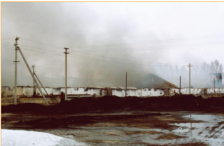
Рис. 2. Зерносклады № 9 и 10 после пожара (вид с юго-восточной стороны)
