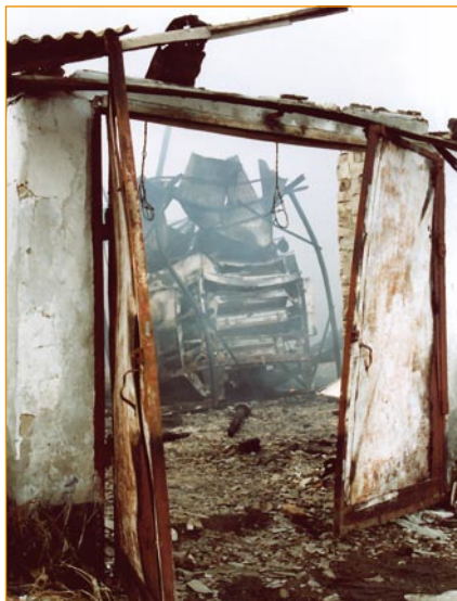
Рис. 3. Деформированная зерноочистительная машина «Петкус-527» (вид через ворота с восточной стороны)
