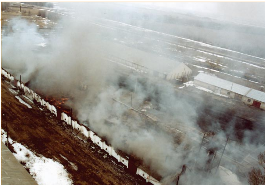
Рис. 1. Зерносклады № 9 и 10 после пожара (общий вид с надсилосного этажа элеватора)
