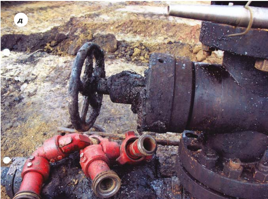
Рис. 1, а–д. Последствия аварии, произошедшей 04.05.05 на скважине 101 Северо-Боганского нефтяного месторождения: а – место происшествия на момент начала работы комиссии по расследованию несчастного случая; б и в – разрушенная установка для ремонта скважин УПА-60А; правая (г) и левая (д) стороны превентора ПМГ-156 после аварии
