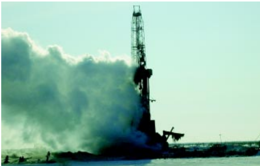
Рис. 1, а. Авария на скважине № 23-П Северо-Варьеганского месторождения нефти
