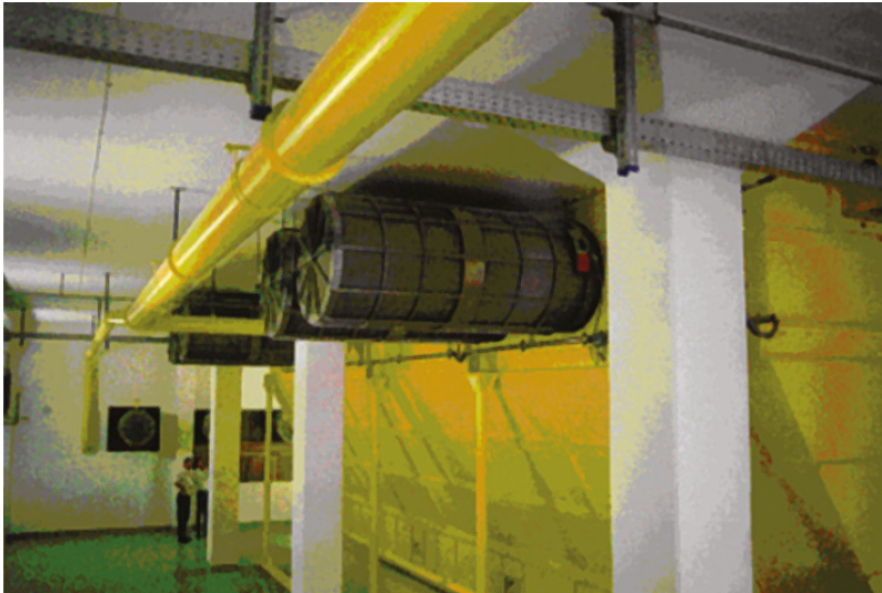
ECO-Q-труба для снятия взрывного давления на емкости с мукой внутри помещения
